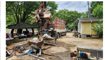
집중호우 피해 발생 특별재난지역 5개 지자체 (영동군·논산시·서천군·완주군·영양군)
